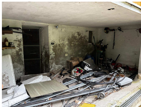
Ripostiglio sub 3 PT
