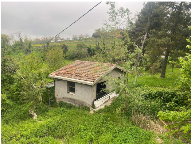
Locale deposito Sub 2
