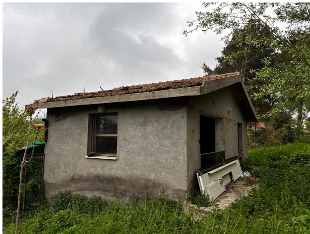
Locale deposito Sub 2
