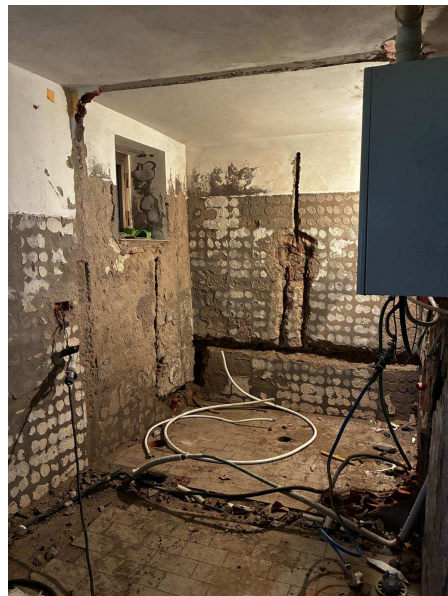
Lavanderia/Bagno sub 3 PT
