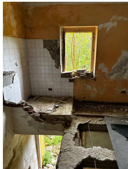
Scala interna sub 1 PT
