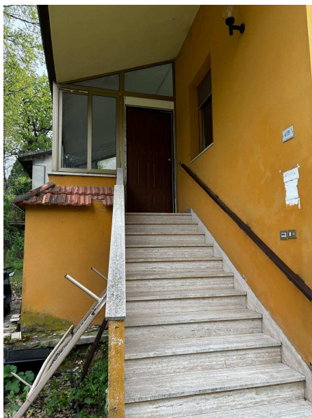
Ingresso scala Sub 3
